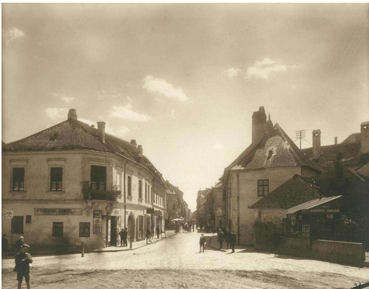
A Jedlik Á. utca kiinduló pontja, eredeti történelmi hangulatán sokat rontott az 1920-as években a középkori épületet „felváltó” bérház.
